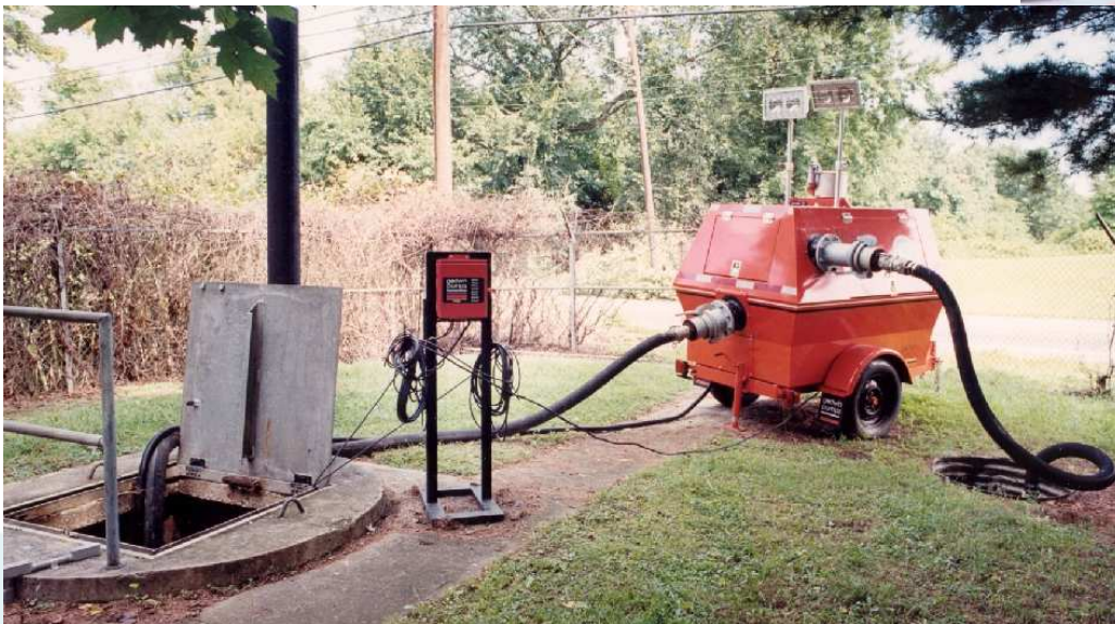
CD150: Desvío en estación de bombeo
