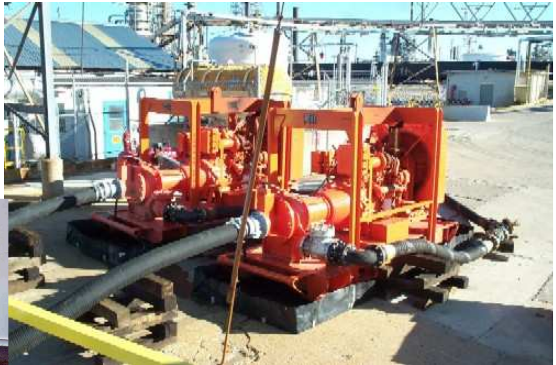
HL160: Sistema temporario anti-fuego en Refineria
