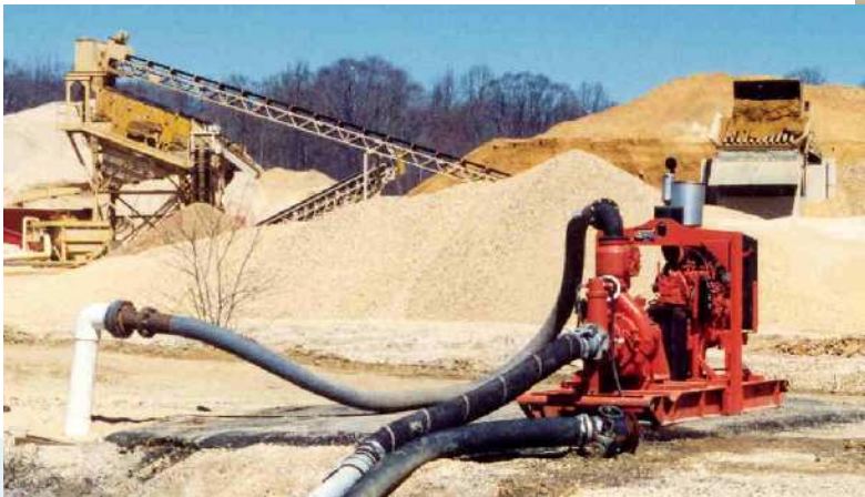
HL200: Planta de Lavado de arena
