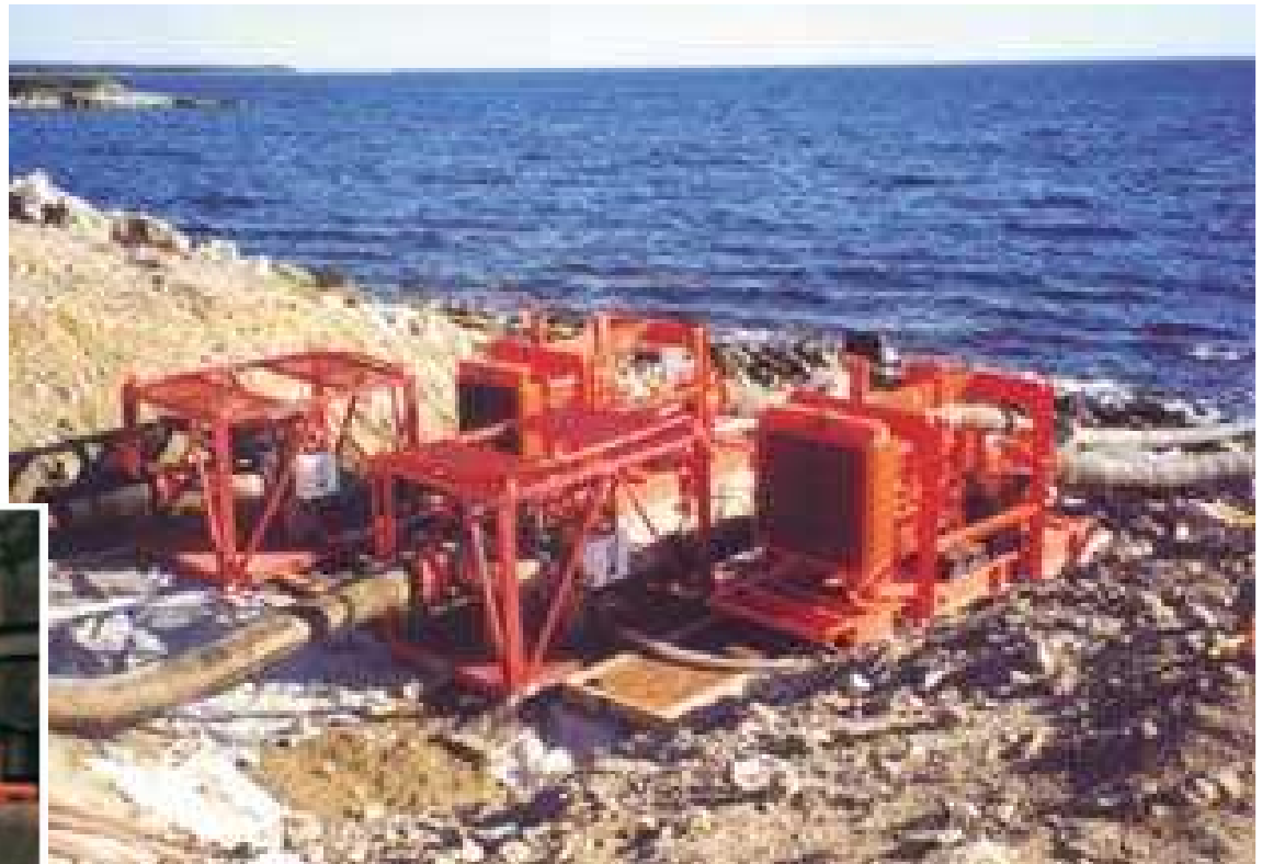
HL250: Prueba hidroestática en tubería de gas
