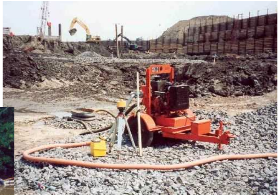
Sitio de desagüe en la construcción del stadium en Philadelphia, PA
